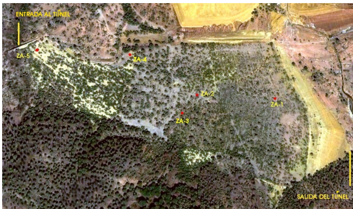
Fotografía 6. Situación de las calicatas sobre la superficie de la Represa III.
