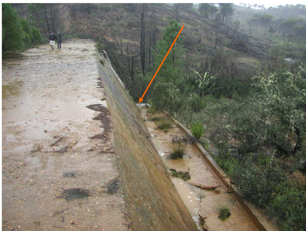
Fotografía 2. Vista del dique occidental de la Represa III. Se destaca la entrada del túnel por el que se canaliza el Barranco del Pie de la Sierra. La fotografía fue tomada en días de fuertes lluvias (noviembre de 2006) y se aprecia el aporte de escorrentía superficial desde el depósito hacia la entrada del túnel.
